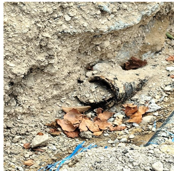
Exemple d'anciennes conduites
